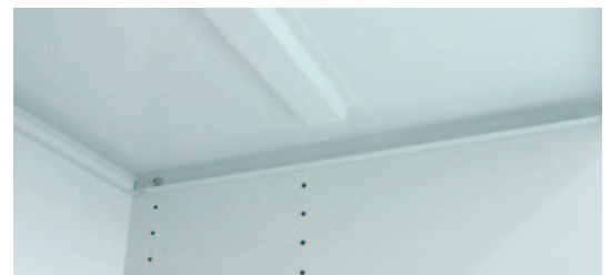
zusätzlich verstärkt mit Hutprofil
